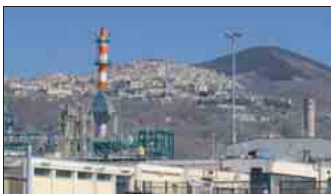
Il Centro olio dell'Eni in Val d'Agri e sullo sfondo Viggiano
