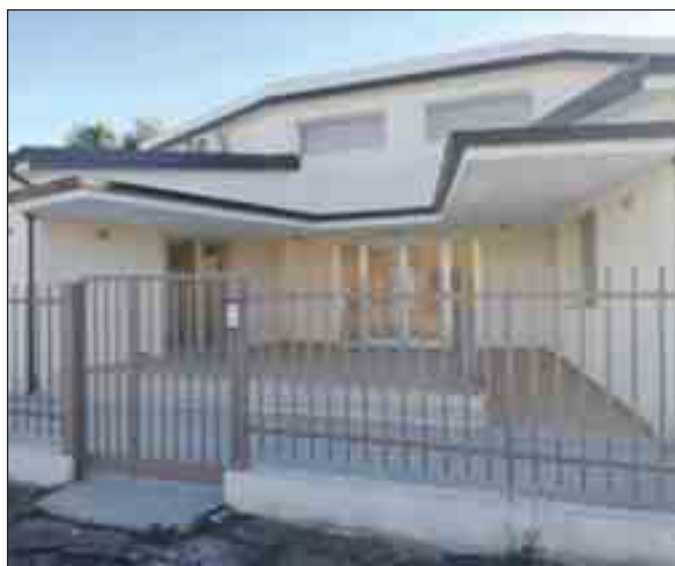
L'asilo nido comunale situato a Centro Agricolo
